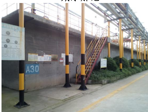
二期活性污泥池
