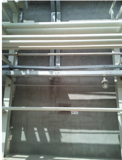
一期水解沉淀池
