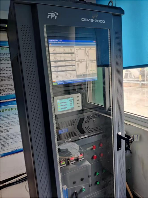
6#RTO 焚烧炉系统在线 CEMS
