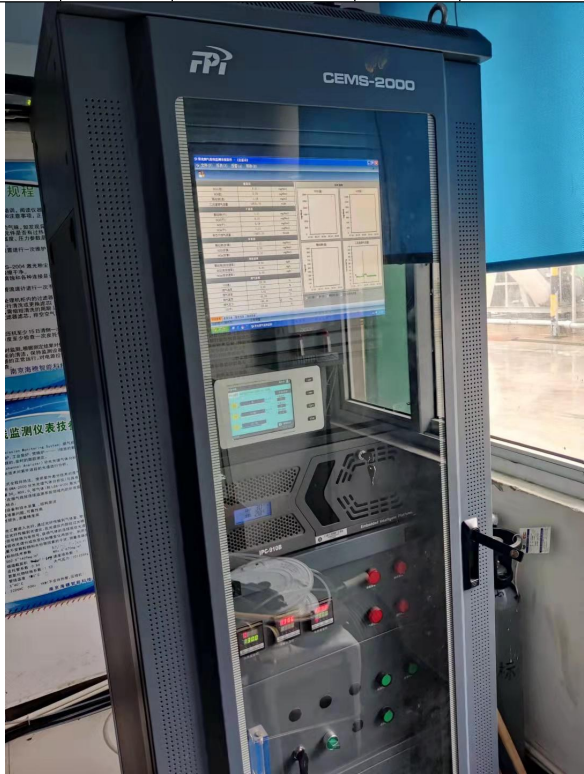
6#RTO 焚烧炉系统在线 CEMS
